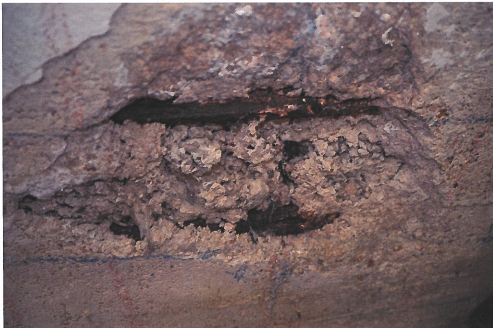
Obr.F47-17 Detail korodující betonářské výztuže na podhledu NK, přibližně 250 mm za lícem první podpěry a 2000 mm od jejího levého čela. Pohled přibližně zleva doprava (proti vodě) a vzhůru, - zplodiny koroze svým tlakem odtrhly nedostatečnou krycí vrstvu poté, co ztratila své pasivační vlastnosti, - jedná se o ojedinělý případ.
