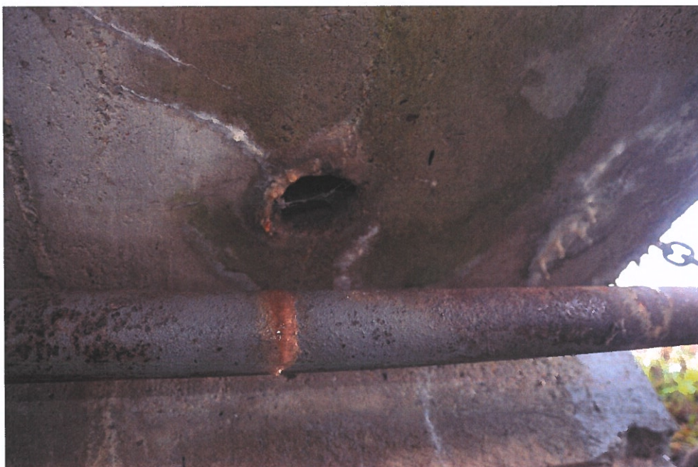
Obr.F47-18 Detail kruhového otvoru \varnothing 100 mm na podhledu desky NK před pravým koncem líce druhé podpěry, budečské opěry. Pohled ve směru staničení, zleva doprava (proti vodě) a vzhůru, - jedná se pravděpodobně o nevyužitý nebo zaslepený prostup pro odpadní troubu mostního odvodňovače, - přes prostup silně zatéká, podhled NK v okolí intenzivně a dlouhodobě (zelené mikroorganismy, inkrustace, krápníky) zamáčen.
